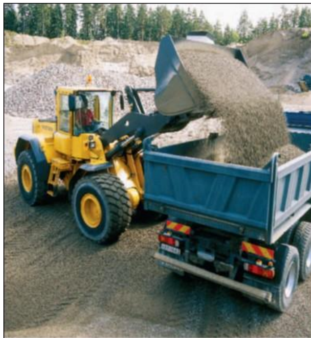
Figura 12. Etapa de carga y descarga del material retirado en el camión de transporte. (Volvo Construction Equipment)
