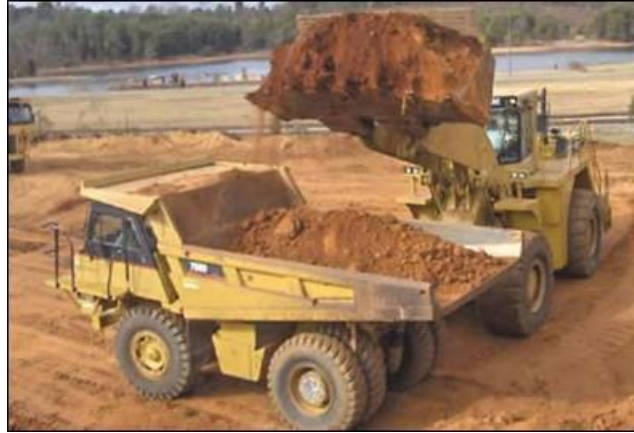
Figura 8. Remoción de tierra y carga hacia la máquina de transporte de material. (Saavedra, 2014)
