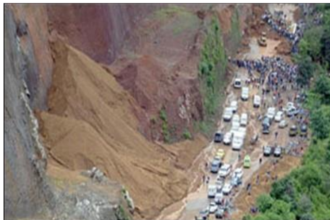
Figura 1. Deslave en carretera. (Saavedra, 2014)
