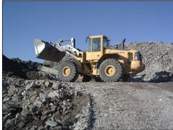
Figura 17. Método práctico de ensayo de terreno y remoción de piedras. (Volvo Construction Equipment)
