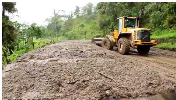
Figura 11. Extendido del terreno. (Yepes, 2015)
