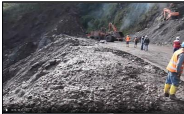
Figura 26. Implementación de la cargadora frontal para limpieza y remoción de tierra en el deslave de la vía Aloag-Santo Domingo. (Gptsachila, 2015)
