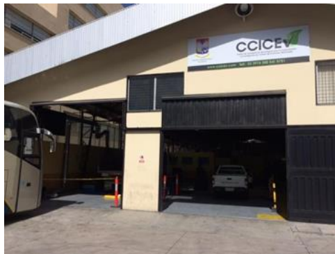
Figura 6. Centro de Transferencia Tecnológica para la capacitación e investigación en control de emisiones vehiculares
